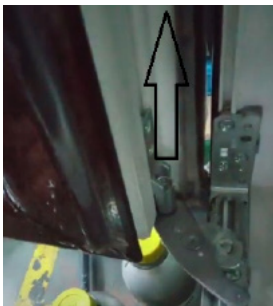
Рис. 5. Снятие створки с нижней петли
