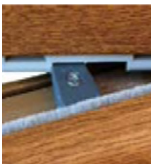
Рис. 10. Величина зазора между опорой европаза и посадочной планкой
