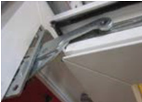
Рис. 8. Установка поворотной створки
