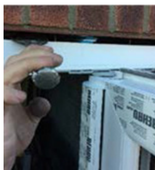
Рис. 11. Корректировка зазора, за счет положения рамы
