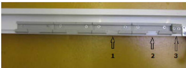
Рис. 3. Посадочные планки 1, 2 и стопор 3 на нижнем/верхнем профиле рамы
